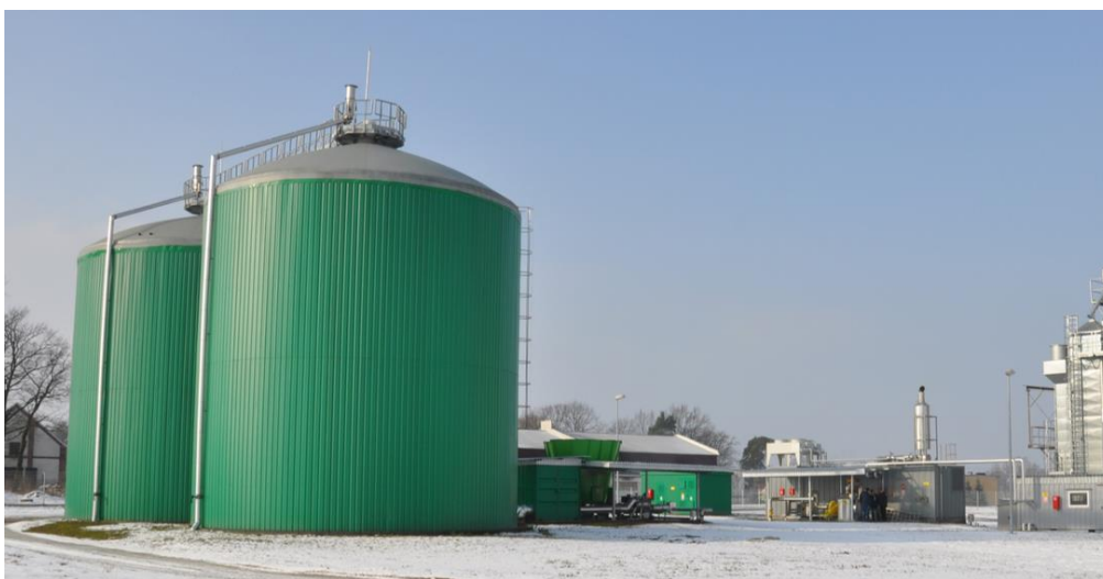
Fot. Biogazownia o mocy 0,4 MW w miejscowości Sieńsk. (archiwum własne autorów).
