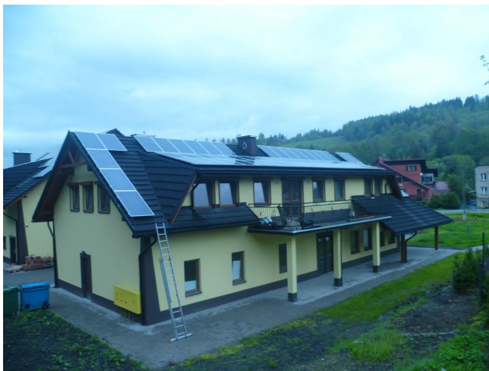
Ryc. Przykład instalacji fotowoltaicznej o mocy 40 kW na hotelu. (archiwum własne autorów).
